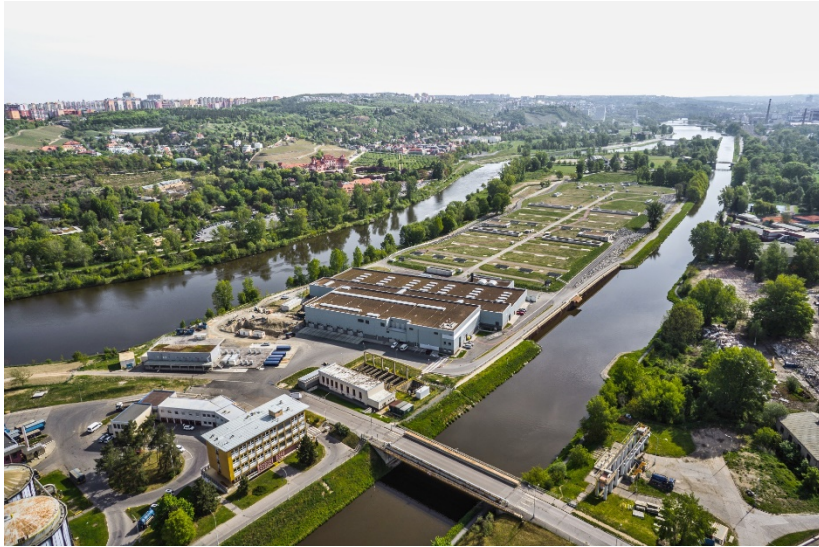
Prag: Kaiserinsel mit unterirdischer Kläranlage
